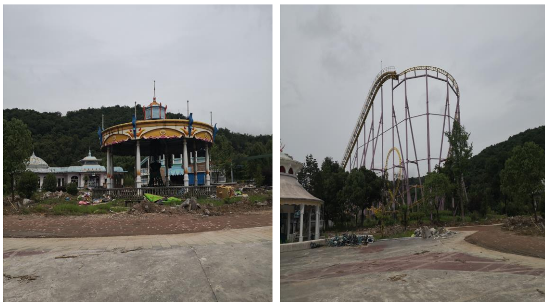
现场踏勘照片
