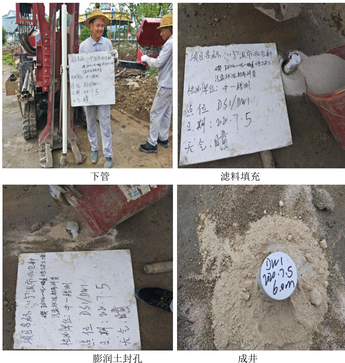
图 6-3 地下水现场建井照片
